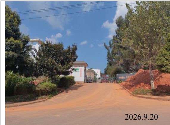
项目西侧的润杰农科公司
