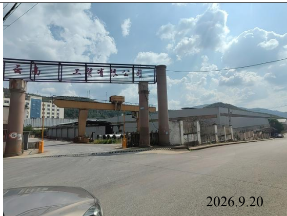
项目南面的三正钢管公司
