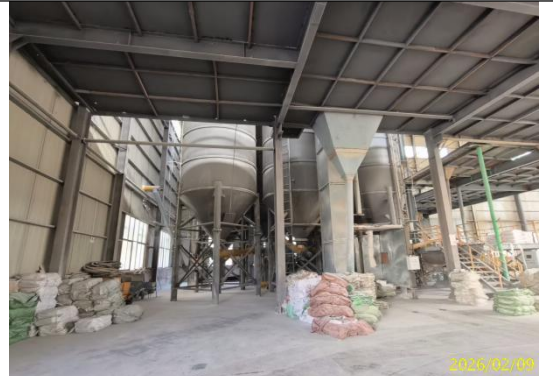
现有石膏砂浆生产车间
