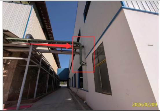
原项目预留的磷石膏输送口
