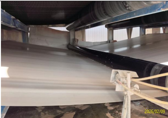
磷石膏压滤洗涤预处理车间
