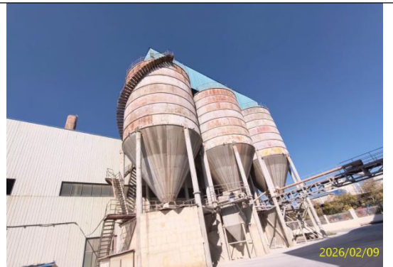
现有工程石膏粉筒仓
