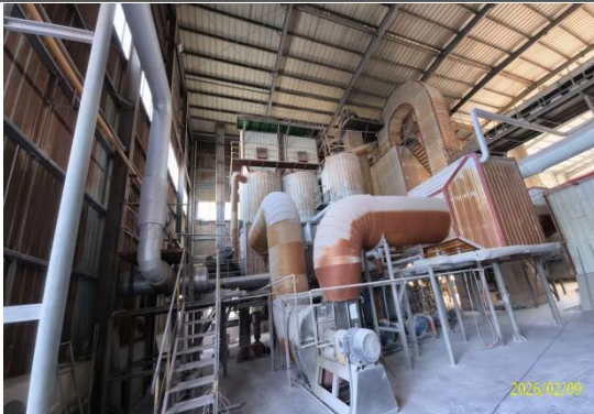
现有石膏粉生产车间
