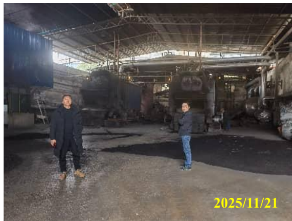
拟改造的锅炉房
