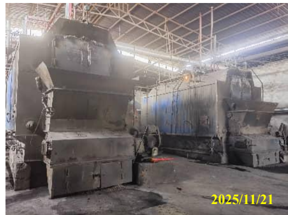
拟拆除的燃煤锅炉
