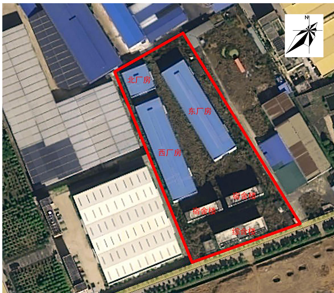
图 2-1 项目区已有建筑物现状
