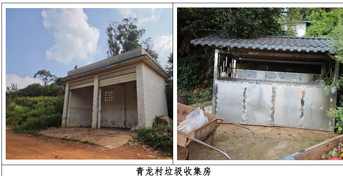
图 2.8.2-2 洛武河水库径流区内垃圾收集设施及运行现状
