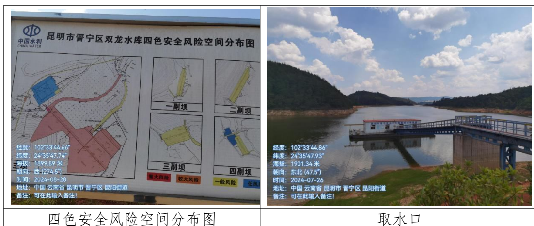
图 2.8.1-1 双龙水库规范化建设现状
