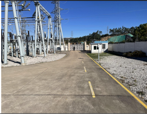
站内道路硬化
