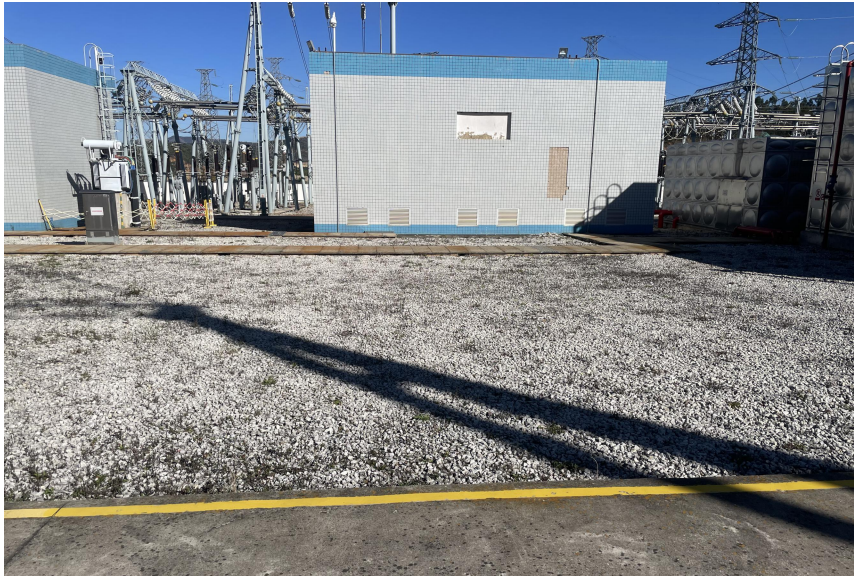
图 4 220kV 樟木箐变电站本期 3#主变扩建预留区域实景照片
