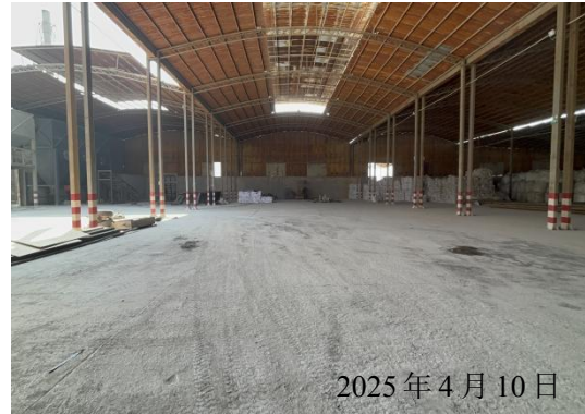
本次技改项目区
