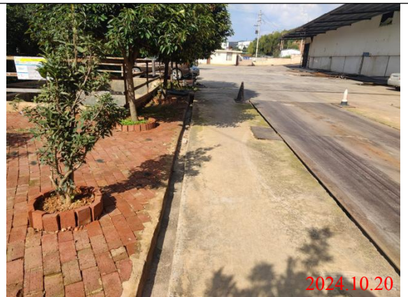
雨水收集沟渠
