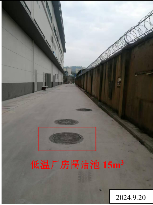
低温厂房隔油池
