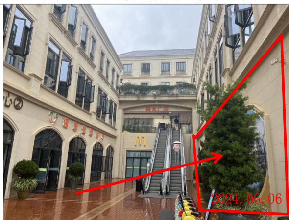
租用的1楼A1建筑物（外部）
