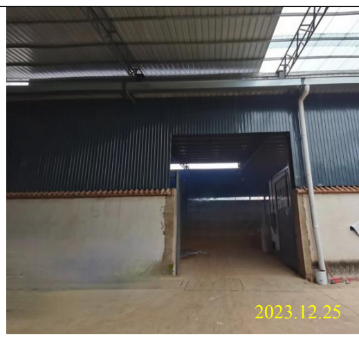
生产车间内部
