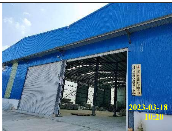
与本项目同厂区的云南膏泽膏泽建材有限公司
